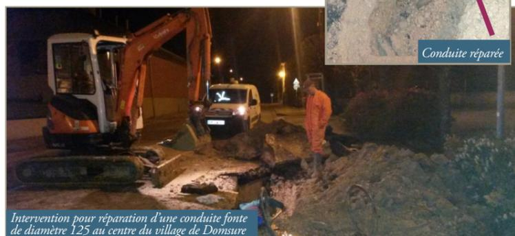
Intervention pour réparation d'une conduite fonte de diamètre 125 au centre du village de Domsure
