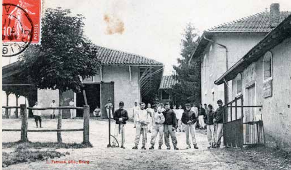
Annexe de Remonte de COLIGNY (Ain) - L'Entrée
